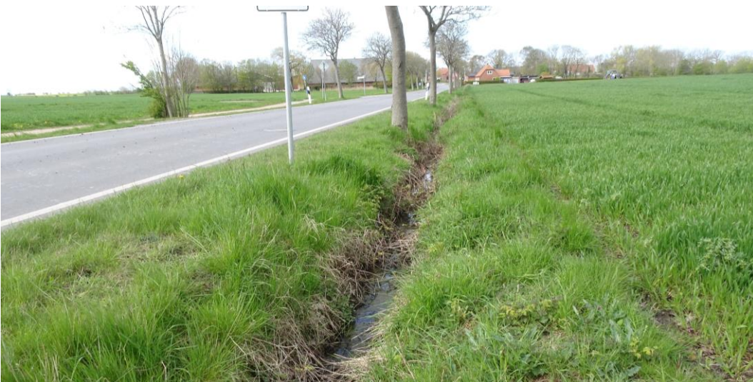
Abb. 6: Zeitweise wasserführender Graben im Bereich der südlichen Zufahrten
