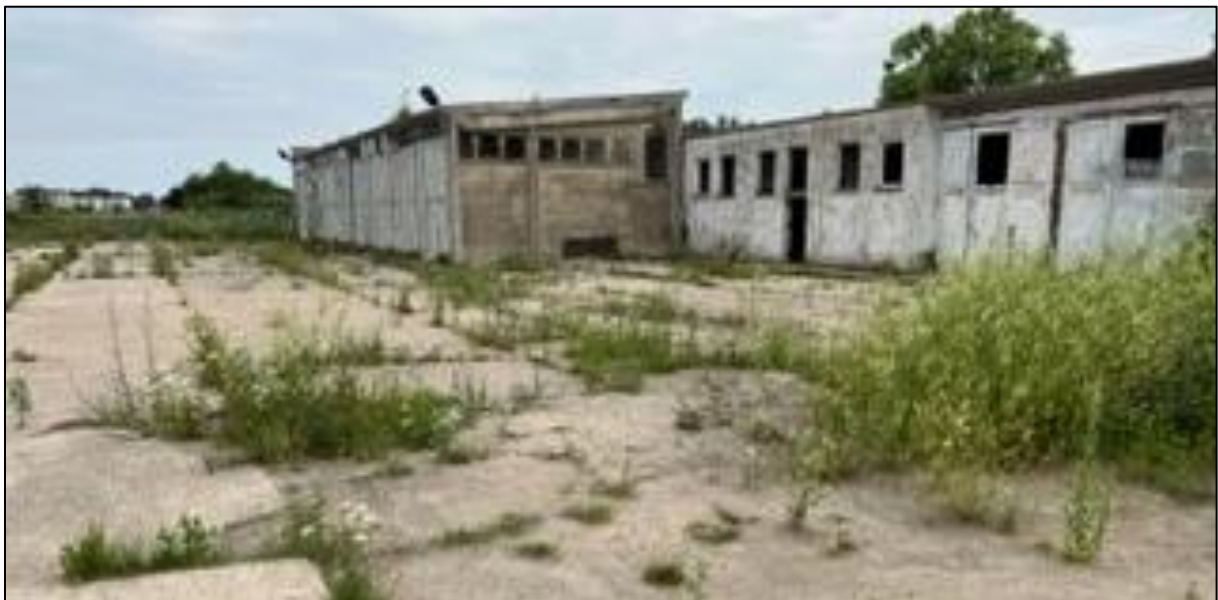
Abbildung 3: Bild vom Planungsraum mit Bestandsgebäude (Juli 2022)
