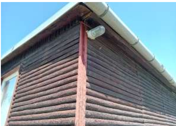
Laube im UG mit diversen Quartiermöglichkeiten durch Spalten zwischen den Balken für Fledermäuse
