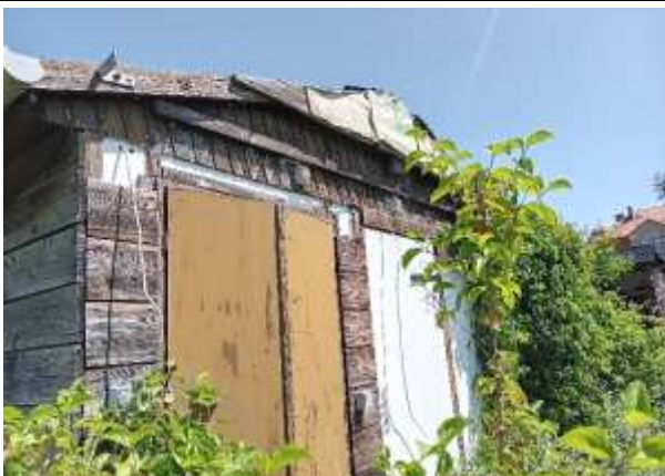
Laube im UG mit diversen Quartiermöglichkeiten für Fledermäuse
