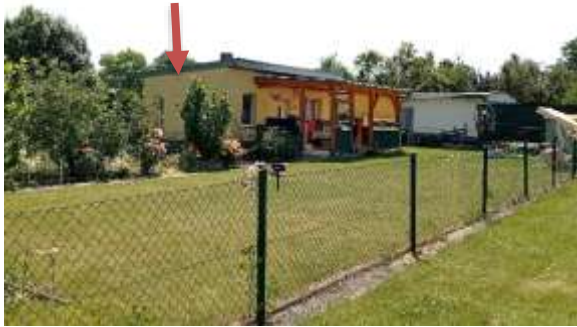
Bewohnte Laube mit Zwergfledermausquartier unter der Attika (s. Pfeil)
