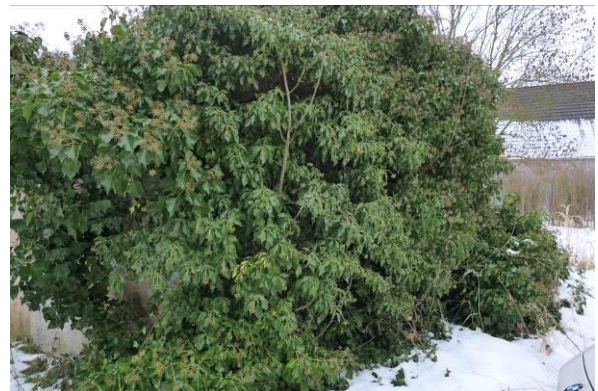
Außenwand (Süd) mit Efeu
