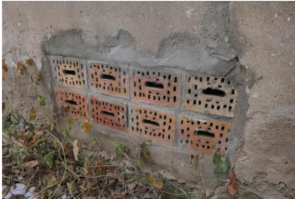
Lüftungsöffnungen
