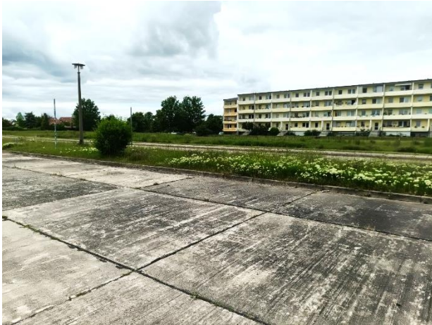
Abb. 2: zentraler Bereich des UG, versiegelte Parkplatzfläche mit Grünlandstreifen, Blickrichtung: West
