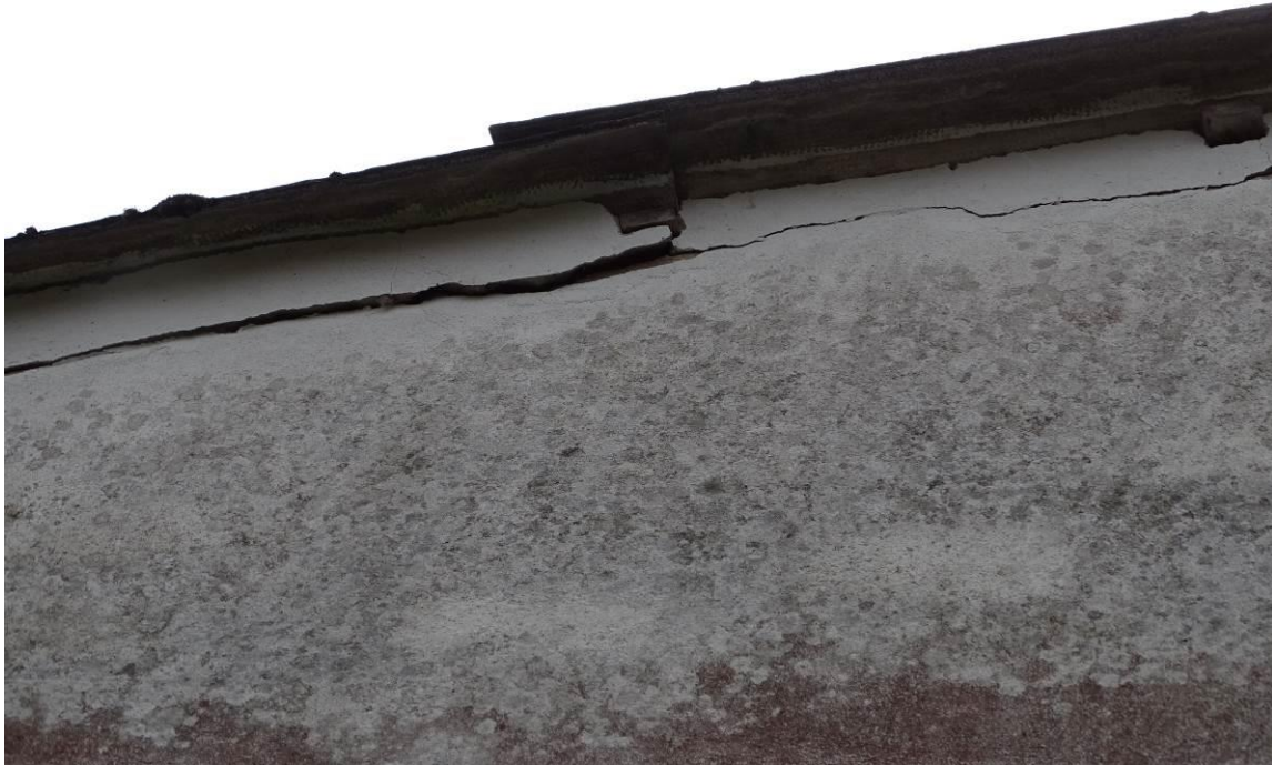
Abbildung 14: Mauerwerksschaden außen (Beispiel)
