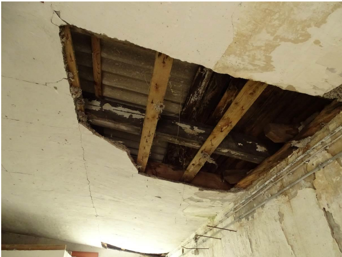
Abbildung 16: Deckenschaden in Werkhalle (Hofseite)
