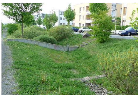
Bild 17: Beispiele Retentionsflächen für die Regenrückhaltung
