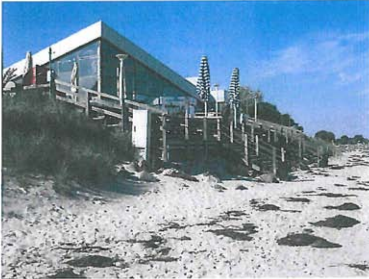
Abbildung 2: Blick vom Strand auf das vorhandene Gebäude im Strandwallbereich sowie die Tribünenanlage
