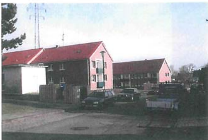
7) Bestehende Bebauung in der Oderstraße
