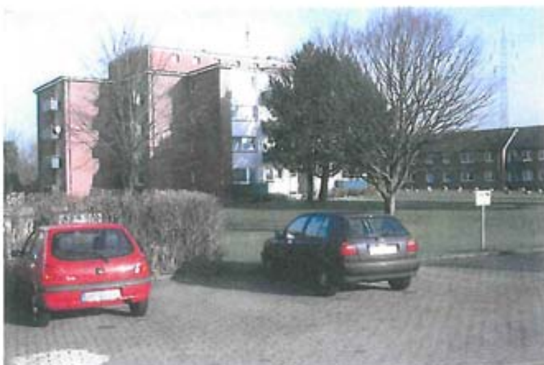
6) Bestehende Bebauung in der Oderstraße
