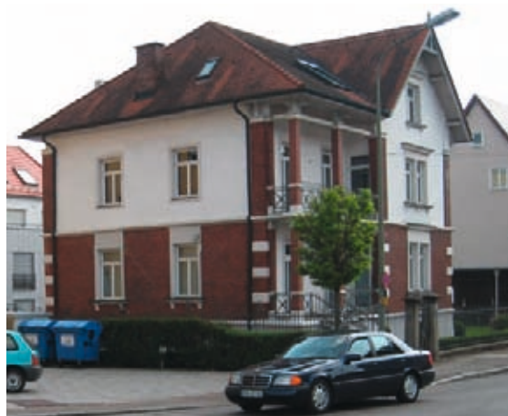
Sanierungsbedürftiges Einzeldenkmal Kugelplatz 7
