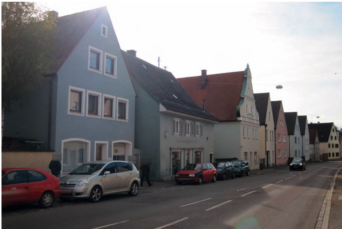
Wohnhäuser aus den 1950er/1960er Jahren am Weidenweg
