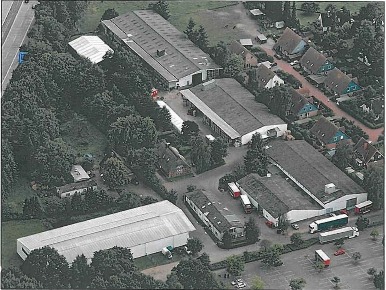
Luftbild des Standortes Sereetz der Rudloff Feldsaaten GmbH (Quelle: Internetseite der Fa. Rudloff)
