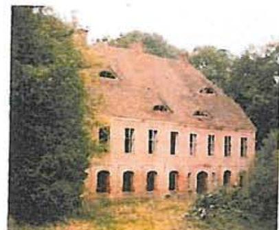
Fassade mit Fledermausluken im Dach
