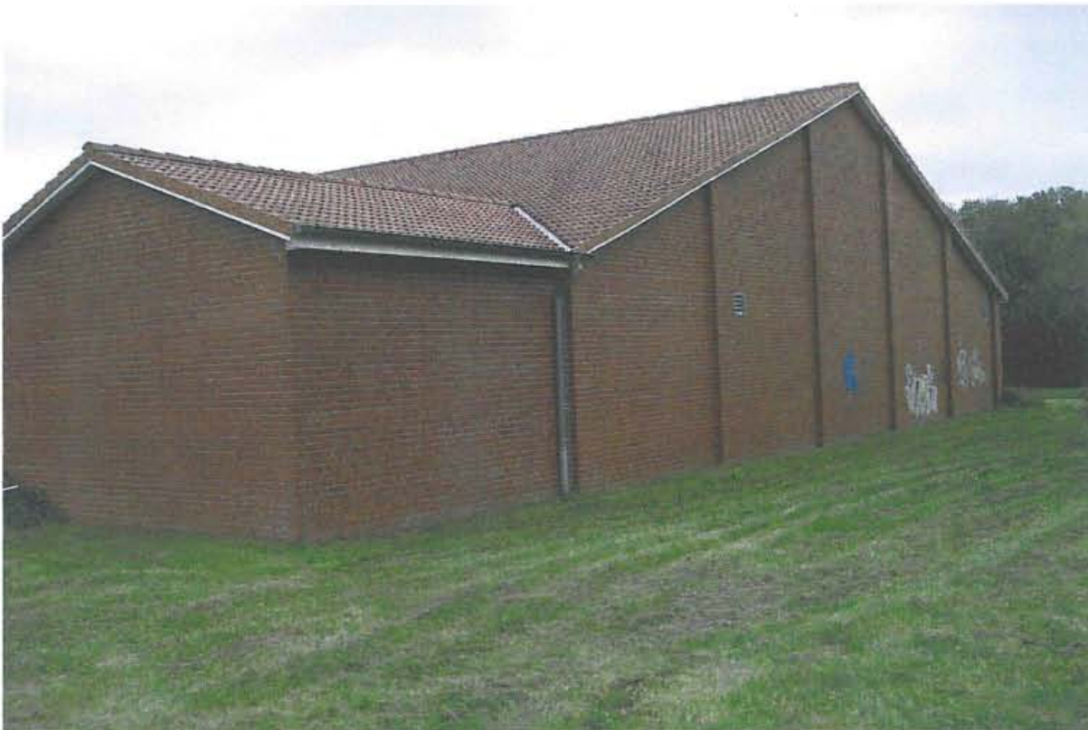
Foto 4: Ansicht des Aldi-Markts, Erweiterungsbereich
