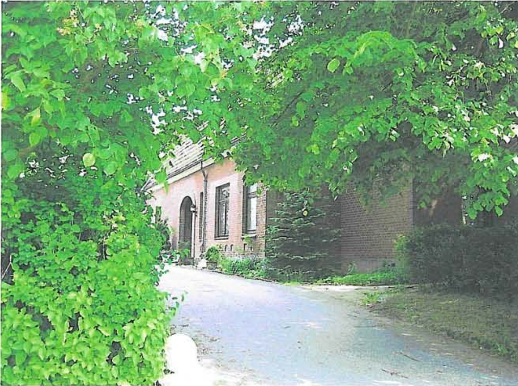
5) Vis a vis zum Plangebiet liegende Bebauung (Hufenkoppel 15)
