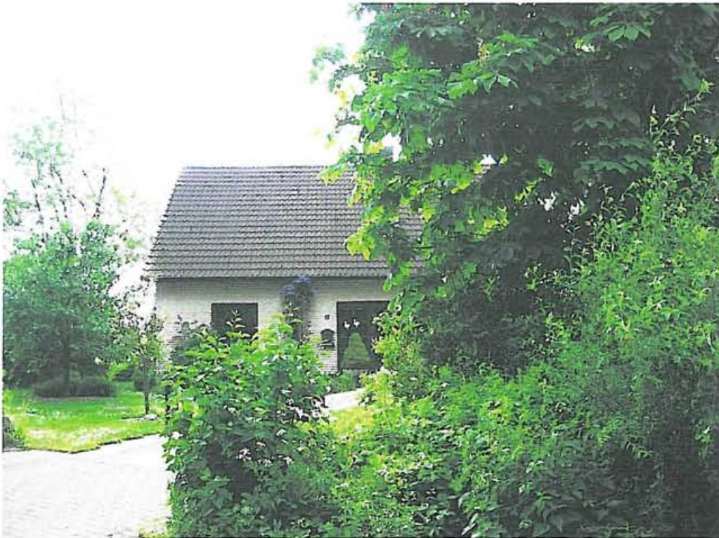
1) Einfamilienhausbebauung Hufenkoppel 17 (Flurstücke 67/15)
