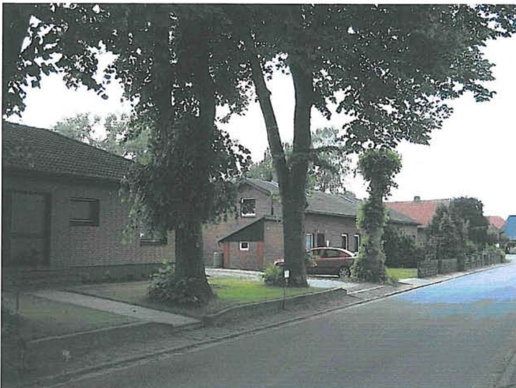
2) Gebäudebestand an der Dorfstraße 34, 36, 38 nebst Straßenbaumbestand
