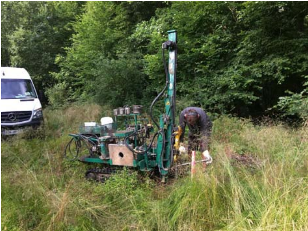
Foto 1: Blick nach Südwesten. Bohrung KRB02.
