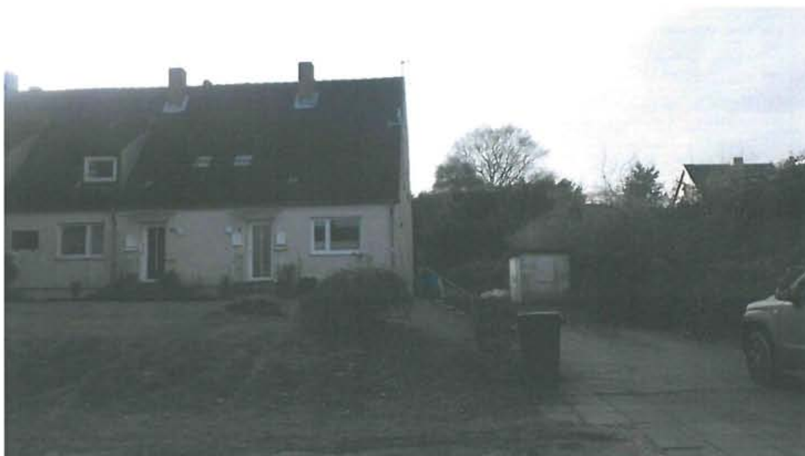
Foto 2: Gebäude 3 (Reihenhaus, Flurstück 89/4)
