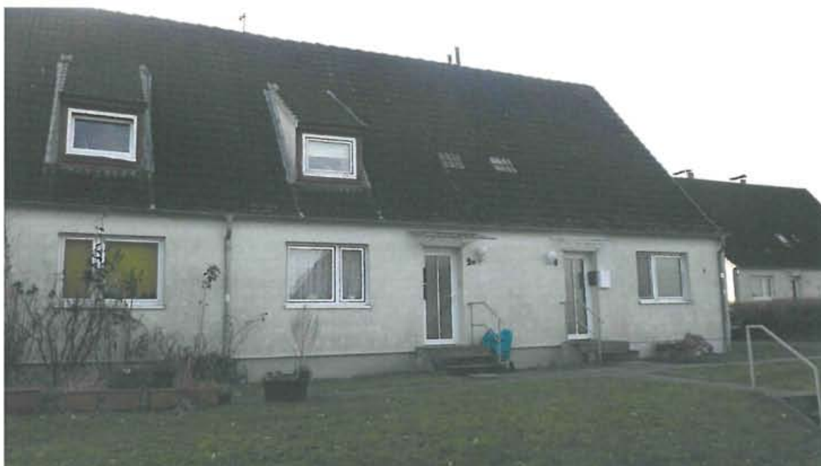
Foto 1: Gebäude 1 (Reihenhaus, Flurstück 89/6)
