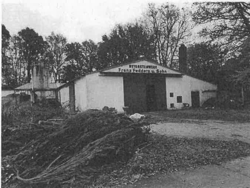
Foto 6 Hallengebäude Produktion / Verladung
