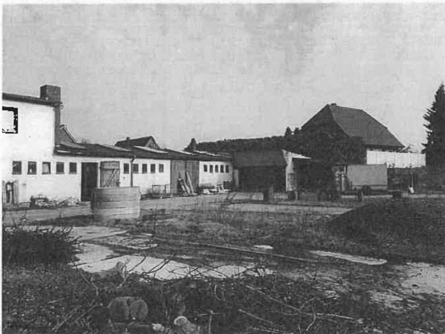
Foto 2 Lager / Magazin und Hoffläche mit Schacht
