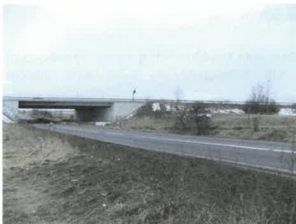
Südliche Blickrichtung entlang der L 40 zur Autobahnbrücke
