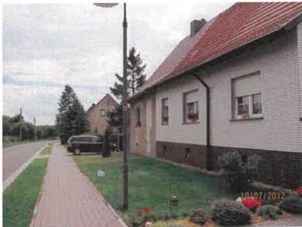
Foto 10 Wohngrundstück aus Norden kommend
