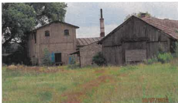
Foto 6 Industriebrache mit Gebäudebestand
