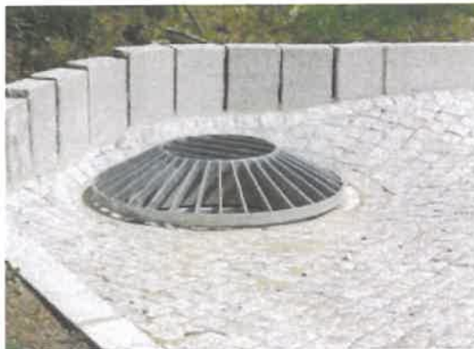
Abbildung 9-1: Gitterabdeckung als Pyramidenstumpf – Beispiel
