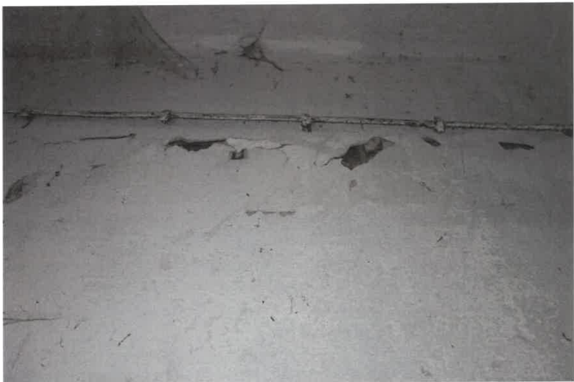
Abbildung 7: Unter den Putzblasen konnten zwar keine Tiere nachgewiesen werden, dennoch sind sie potenzielle Sommer- und Zwischenquartiere.
