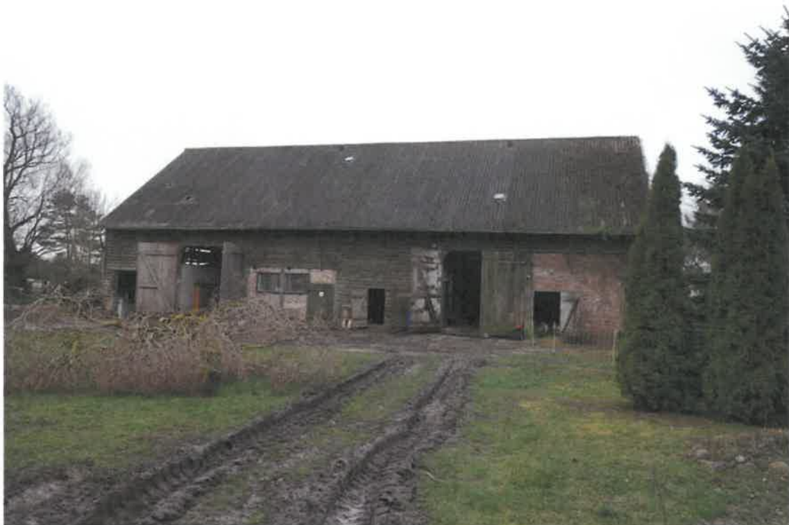
Abbildung 4: In Nutzung befindliches Wirtschaftsgebäude im Süden des Dreiseitenhofes. Hier können die Ersatzmaßnahmen durchgeführt werden.
