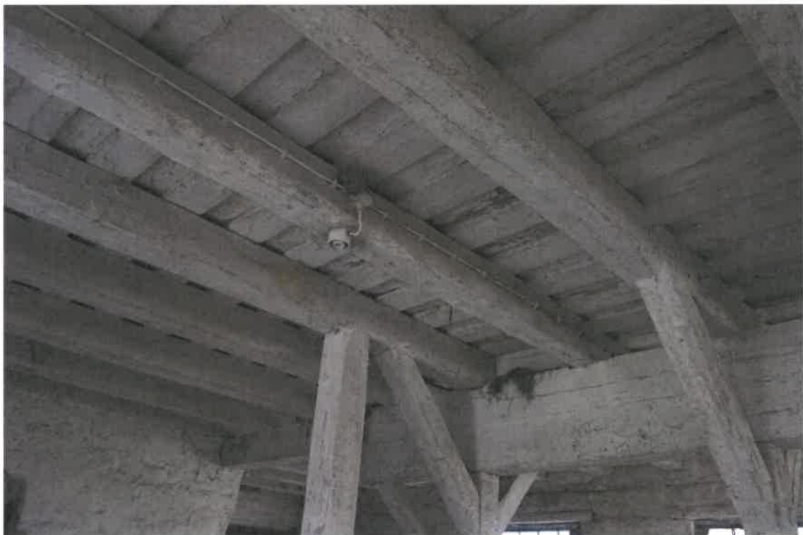
Abbildung 5: Rauchschwalbennest am Deckenbalken sowie Hausrotschwanznest auf dem Trägerbalken im ehemaligen Stallbereich.
