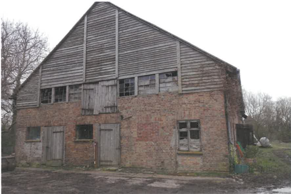
Abbildung 3: Westliche Giebelseite des alten Wirtschaftsgebäudes
