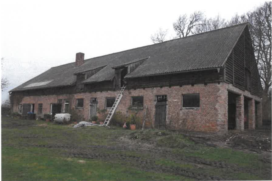
Abbildung 2: Das alte Wirtschaftsgebäude im Norden des Dreiseitenhofes, von Südwesten gesehen.
