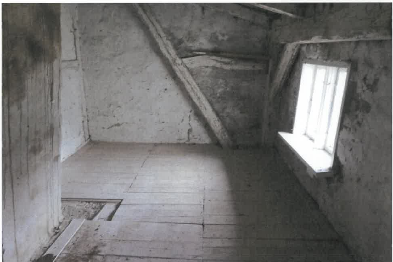
Abbildung 10: Nicht ausgebauter Bereich des Dachbodens.
