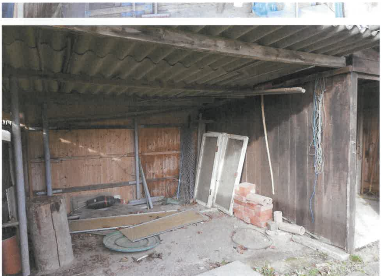
Abbildung 14: Offene Bereiche des Gebäudes 2.
