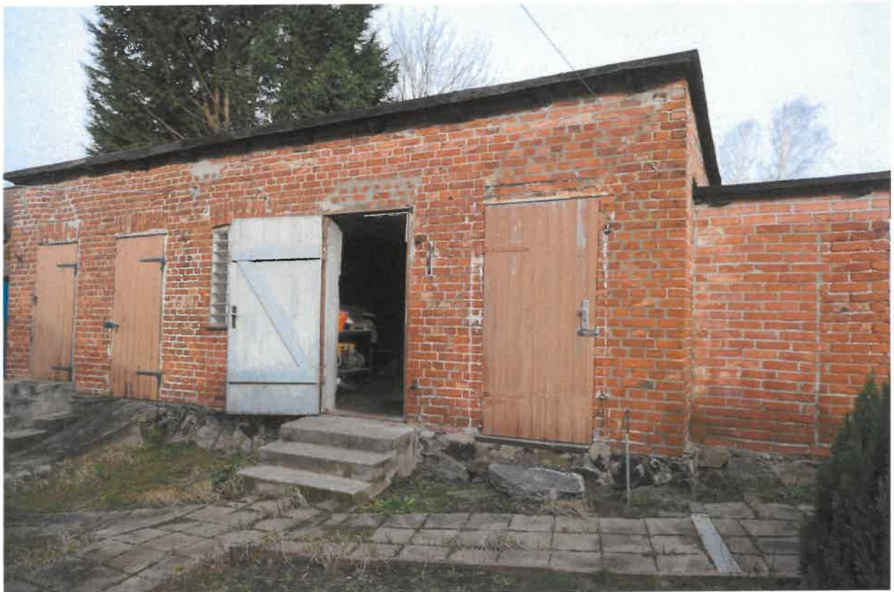
Abbildung 11: Sicht aus Süd auf Gebäude 2.
