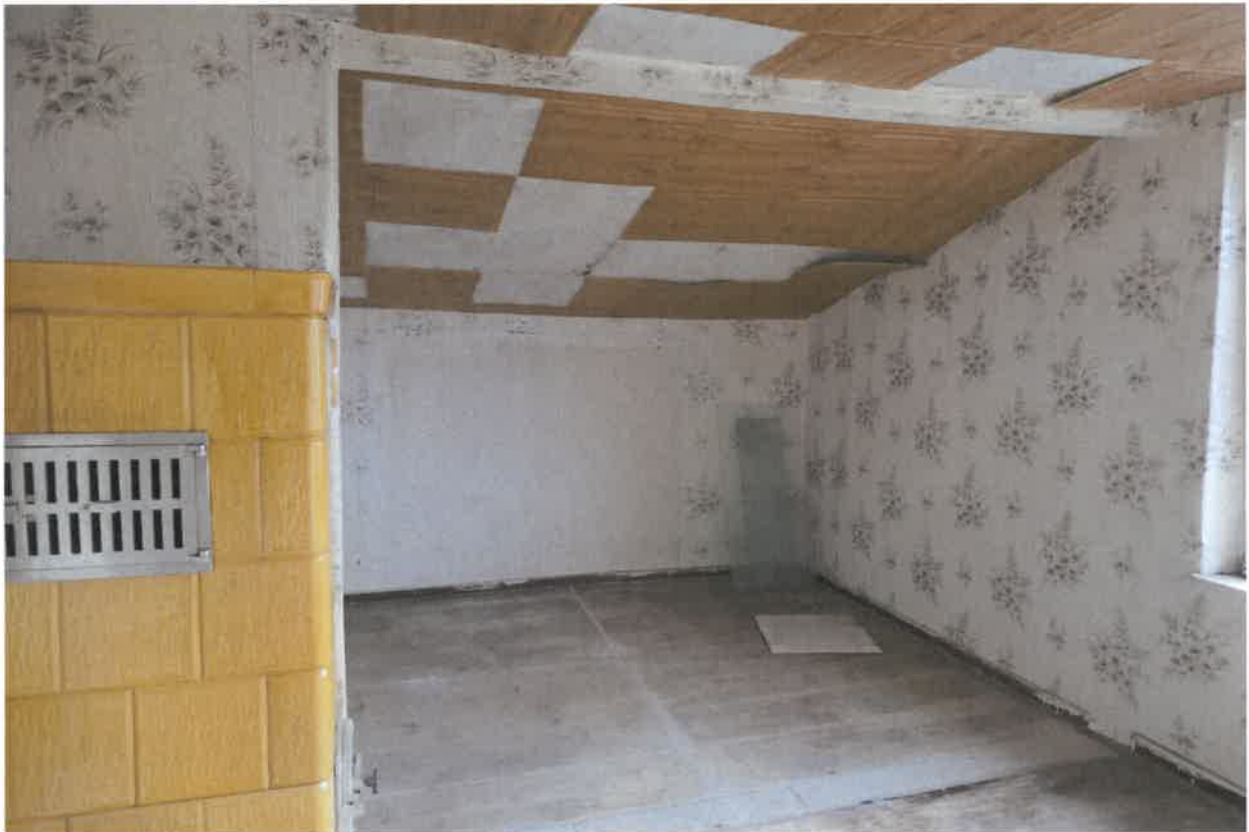
Abbildung 9: Innenansicht im ausgebauten Dachgeschoss des Wohnhauses.
