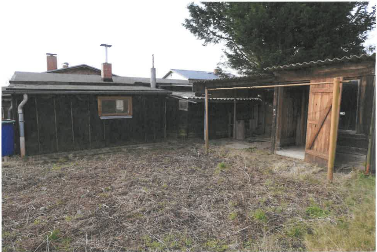
Abbildung 13: Blick aus Nord auf Gebäude 2.
