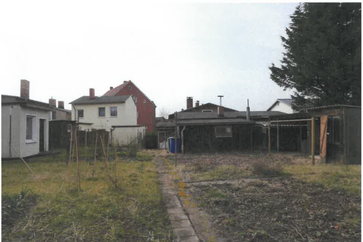
Abbildung 18: Der Gebäudebestand von der Hofseite aus gesehen.
