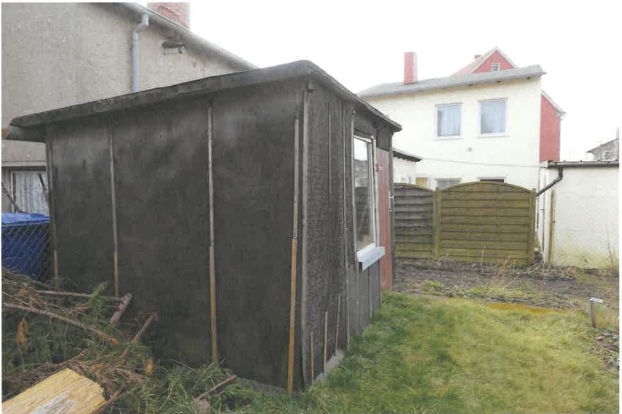
Abbildung 17: Gebäude Nr. 3 aus nördlicher Sicht.
