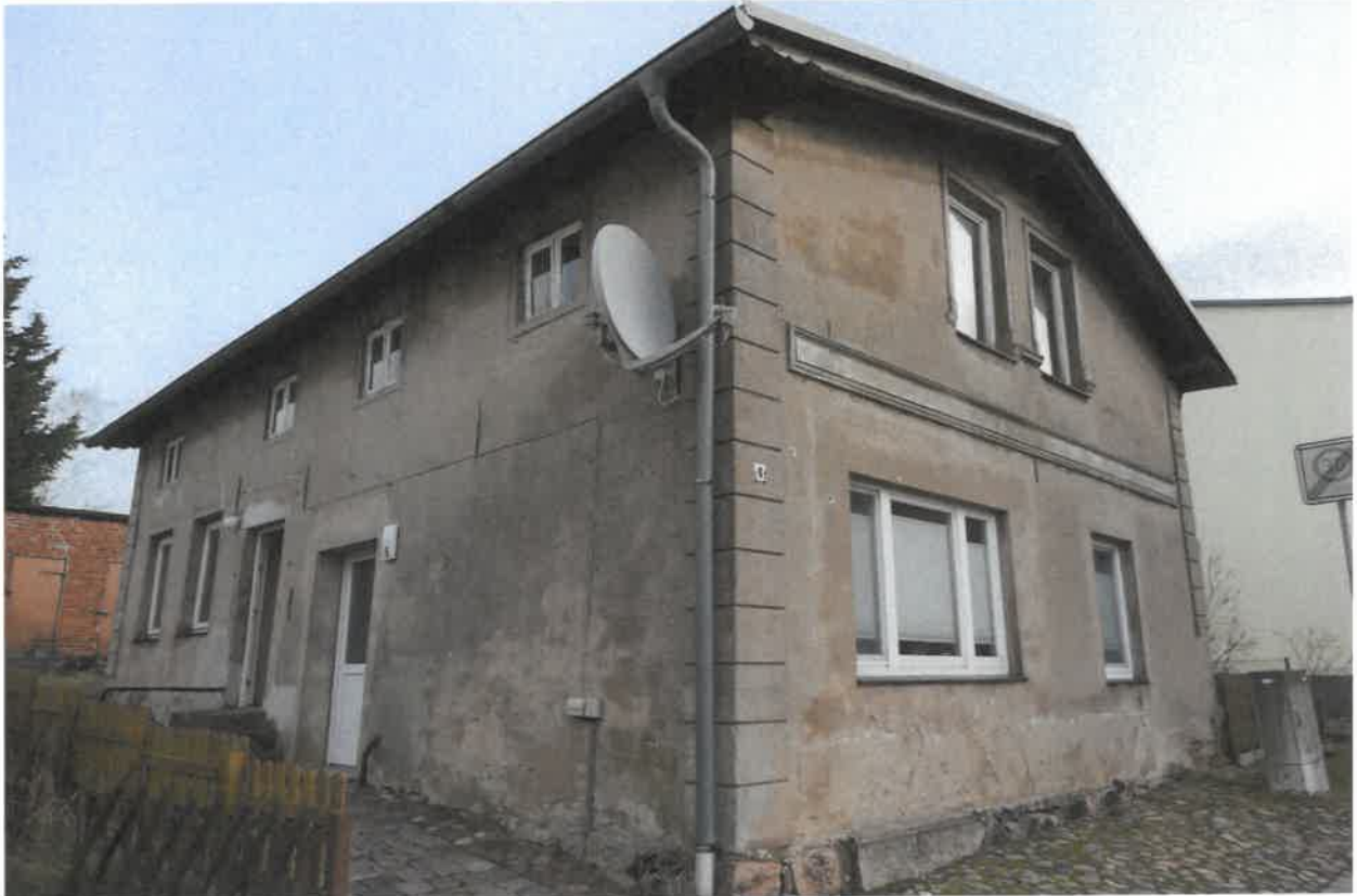
Abbildung 3: Ansicht des Wohnhauses (1) von der Straßenseite.
