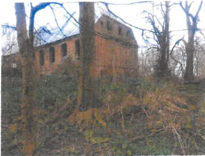
Abbildung 2: Blick auf das Baugrundstück
