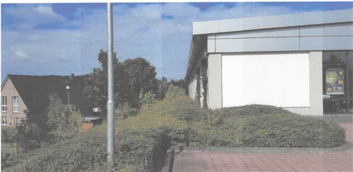
Abbildung 6: Bewuchs am rückwärtigen Gebäudebereich, wo nach Süden hin keine bauliche Erweiterung stattfinden soll. (Quelle: Büro für Bauleitplanung)
