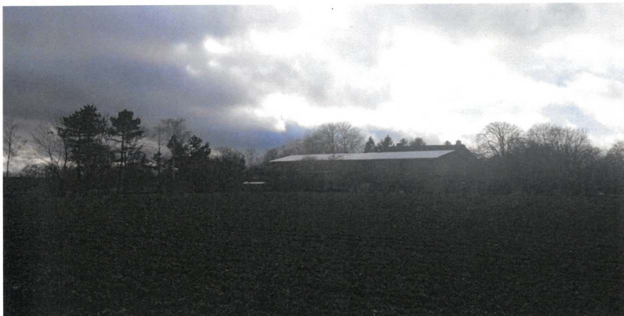
Bild 4.5.3: Blick von Osten auf das Wirtschaftsgebäude (Quelle: SolPEG)
