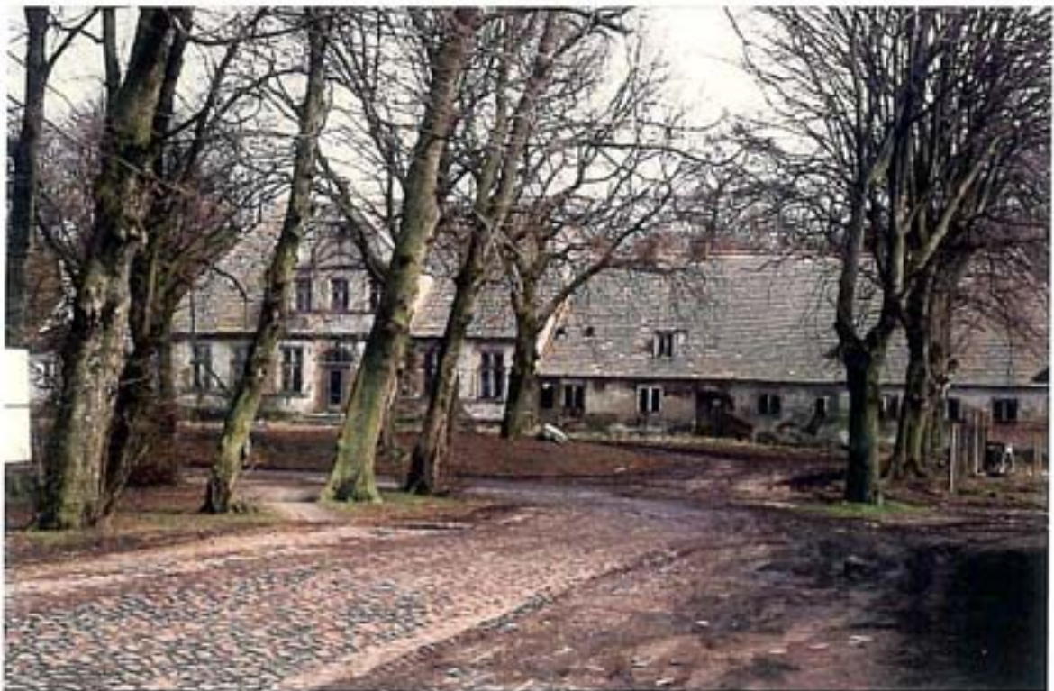
Das ehemalige Mustergut Parchow ist in sehr baufälligem Zustand; charakteristisch ist die Parkanlage mit altem Baumbestand Foto: Eingangssituation von Parchow
