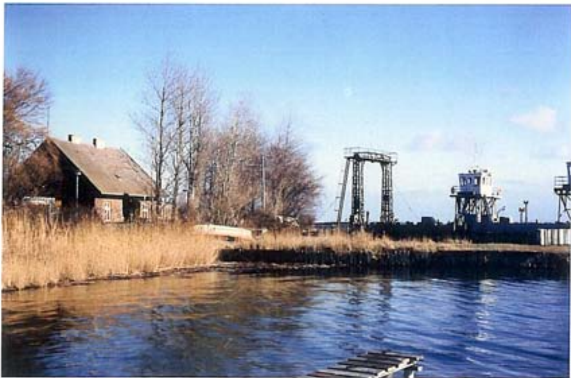
Der Anleger Wittower Fähranlage ist als Kulturdenkmal ausgewiesen (Portalanlage) Foto: Wittower Fähranlage
