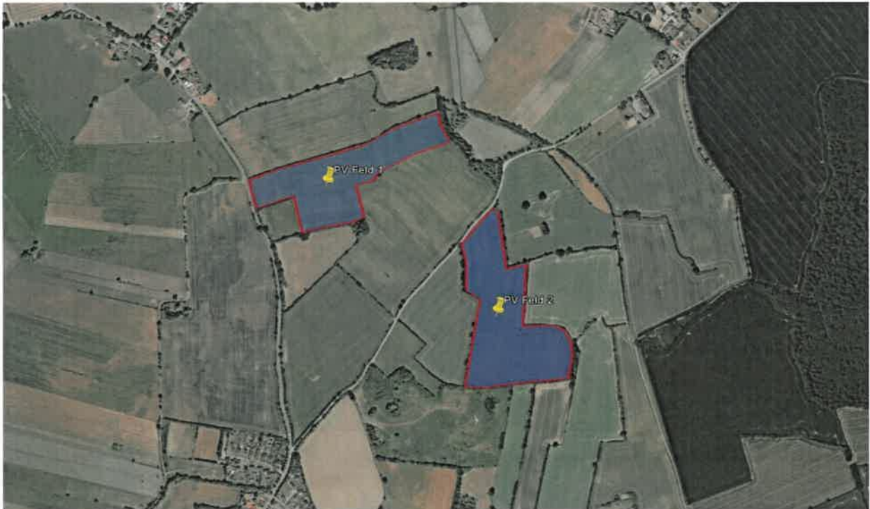
Bild 2.1.2: Luftbild der PV Anlage (Quelle: Google Earth / SolPEG)
