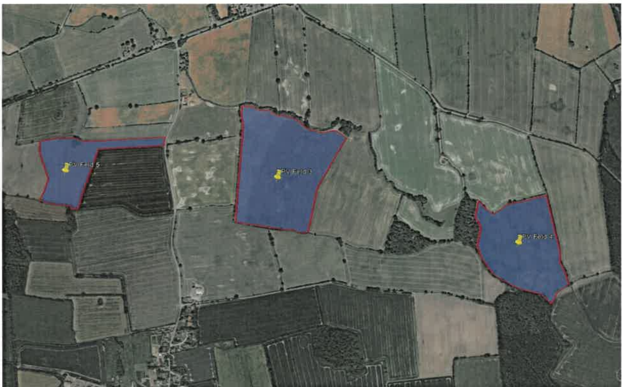
Bild 2.1.3: Luftbild der PV Anlage (Quelle: Google Earth / SolPEG)
