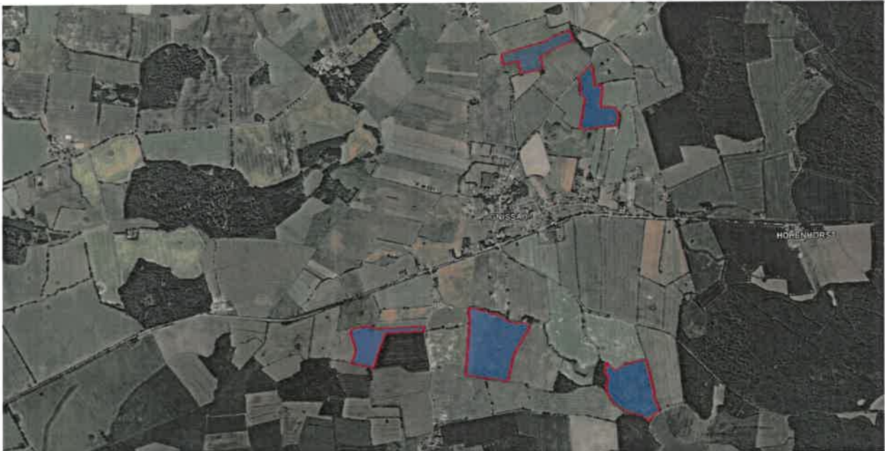
Bild 2.1.1: Luftbild der PV Anlage (Quelle: Google Earth / SolPEG)
