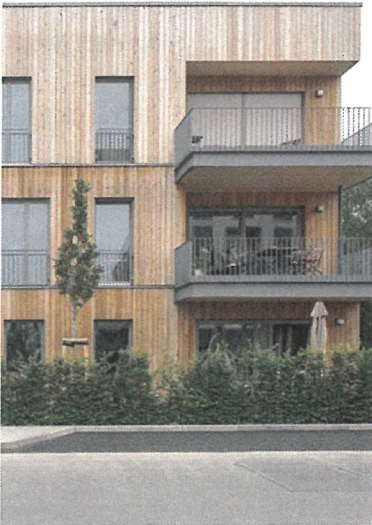
Beispiel massive Holzkonstruktion
