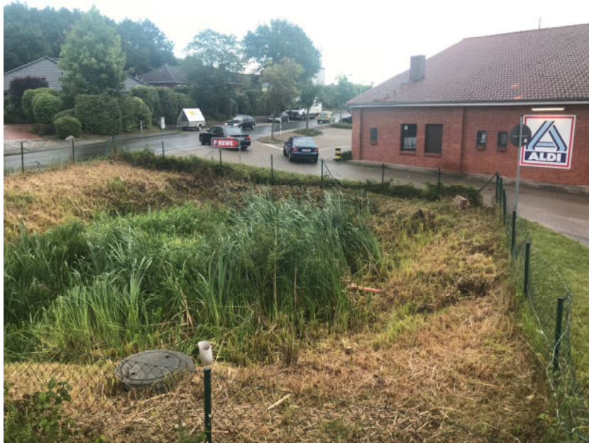
Bild 1: Blick auf das Rückhaltebecken mit Überlaufrohr, Ablaufschacht, Anlieferungszufahrt
