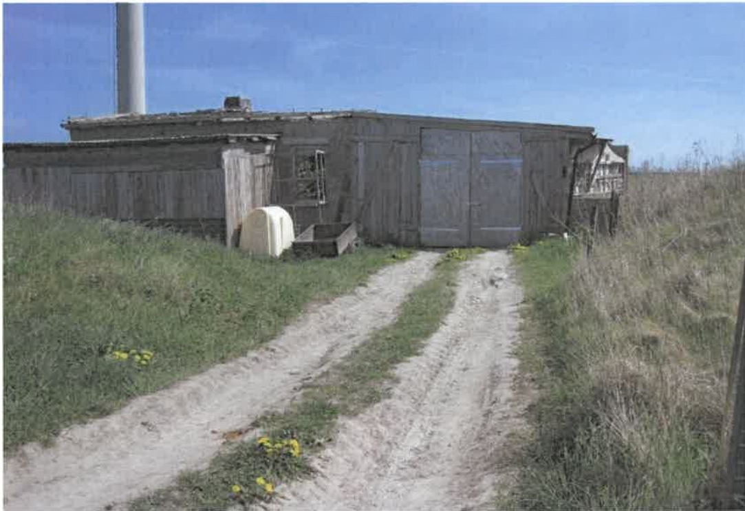
Abbildung 35: Holzschuppen an der westlichen und südlichen Seite des gemauerten Gebäudes
