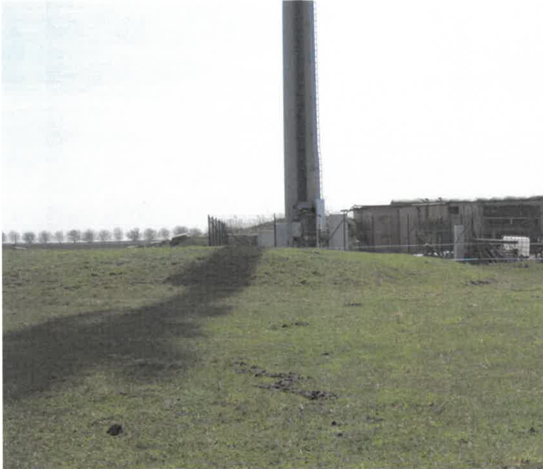
Abbildung 37: Bereich des Funkturmes (außerhalb des PGs), im Hintergrund Bodenmiete und landwirtschaftliche Gebäude
