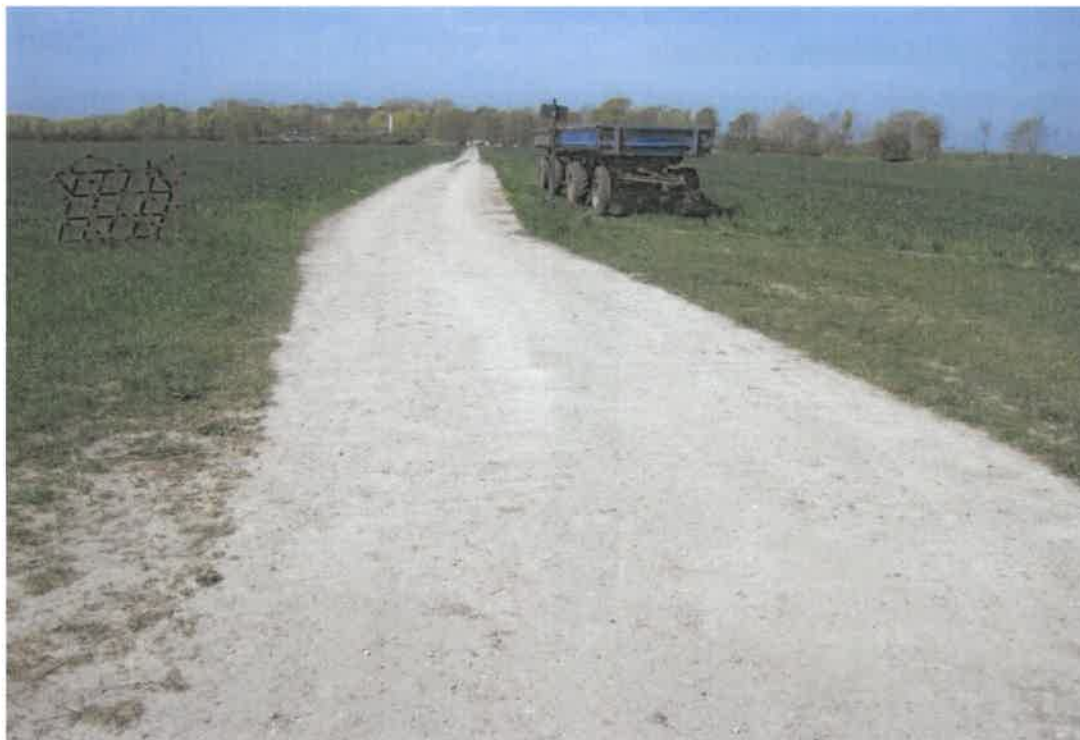
Abbildung 38: Zufahrtsweg, Blick Richtung Westen
