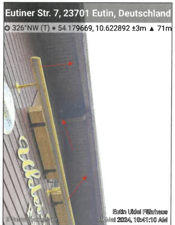
Abbildung 30: Mehlschwalbennester am Dachüberstand Östseite von Gebäude 1 (Foto: Planungsbüro ALSE, 29.05.2024)
