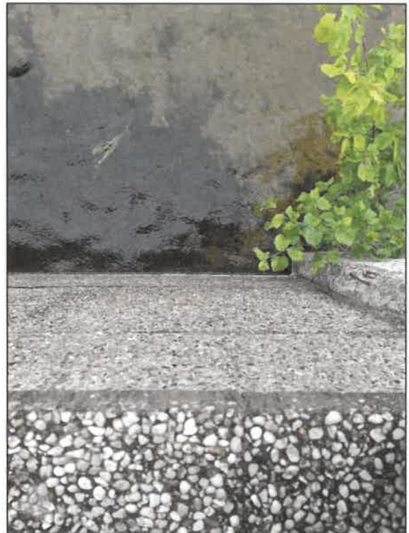
Abbildung 60: Massive Uferbefestigung am Kellersee (Foto: Planungsbüro ALSE, 29.05.2024)
