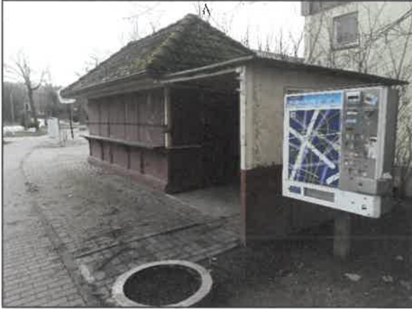
Abbildung 5: Imbissbude / Kiosk (Gebäude 3) an der Eutiner Straße (Foto: Planungsbüro ALSE, 20.02.2024)
