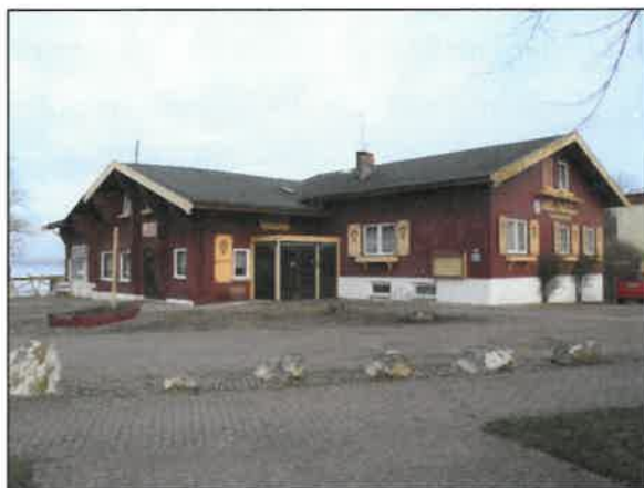
Abbildung 3: Restaurant und Café Ukleifährhaus (Gebäude 1), Blick aus Süden (Foto: Planungsbüro ALSE, 23.03.2024)
