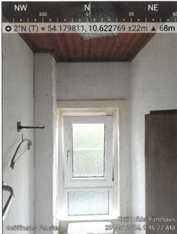
Abbildung 46: Geöffnetes Fenster, Nordseite von Gebäude 1 (Foto: Planungsbüro ALSE, 29.05.2024)
