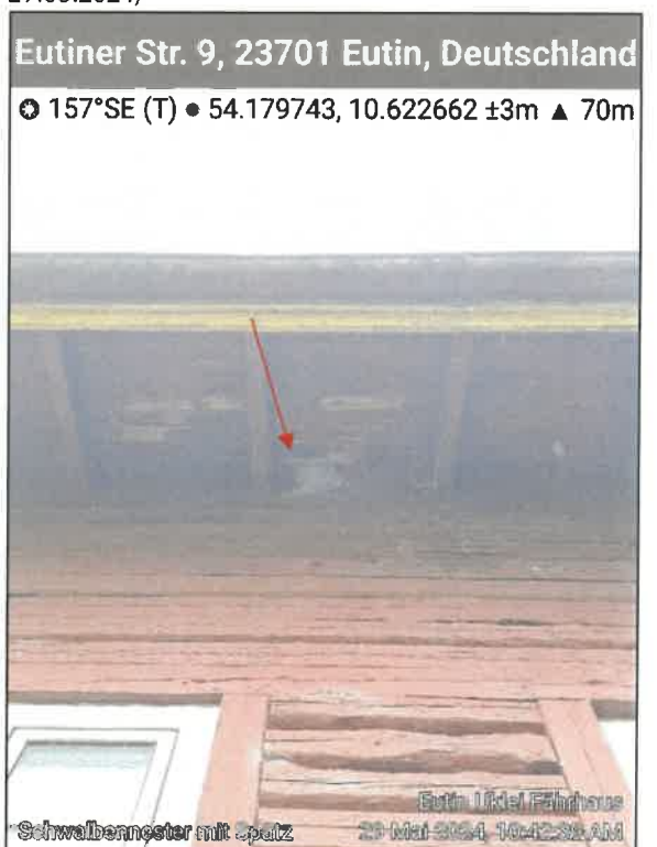
Abbildung 32: Mehlschwalbennest mit brütendem Haussperling an der Nordseite von Gebäude 1 (Foto: Planungsbüro ALSE, 29.05.2024)
