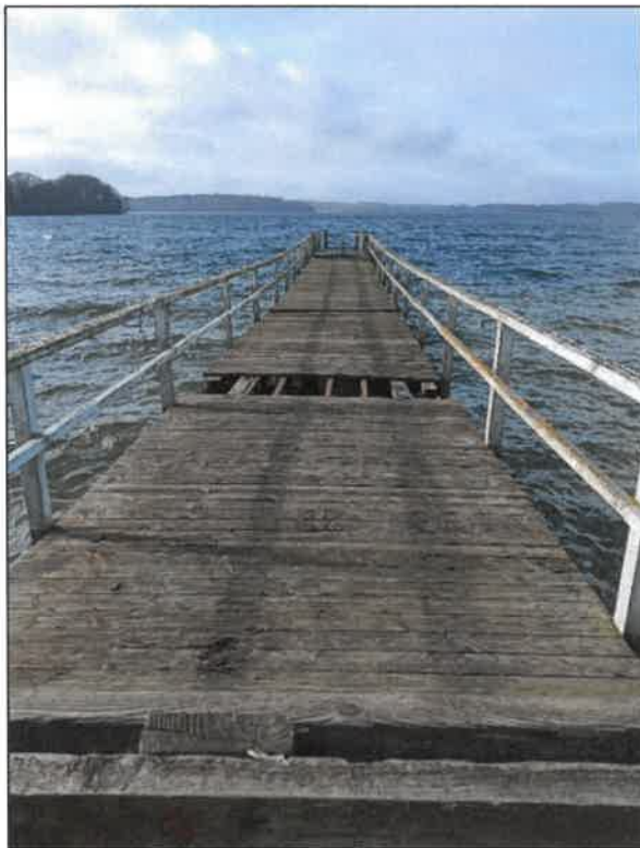
Abbildung 6: Bootsanleger/Steg am Kellersee (Foto: Planungsbüro ALSE, 20.02.2024)
