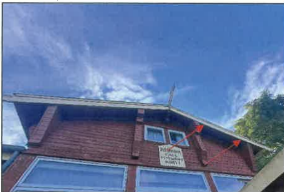
Abbildung 39: Spalten und Nischen im Bereich des Dachüberstandes an der Westseite von Gebäude 1 (Foto: Planungsbüro ALSE, 16.06.2024)
