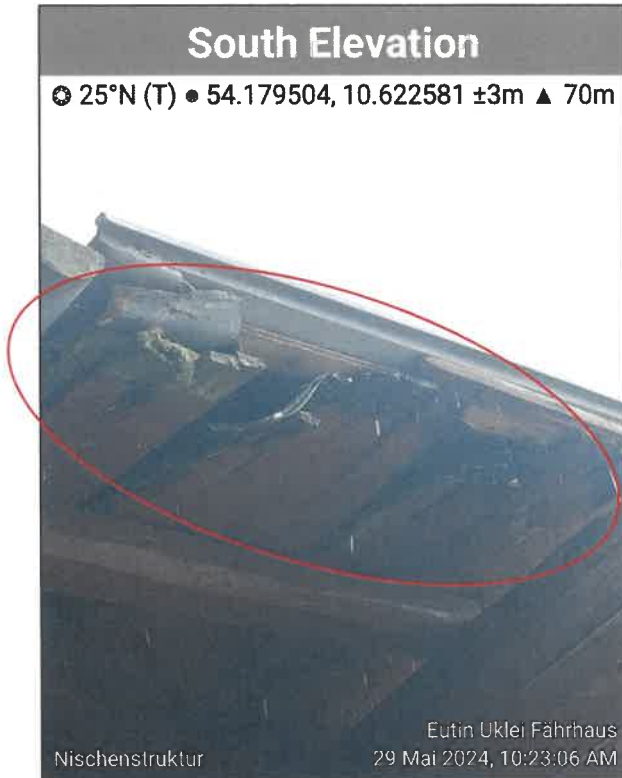
Abbildung 17: Nischenstrukturen am Dachüberstand (Foto: Planungsbüro ALSE, 29.05.2024)
