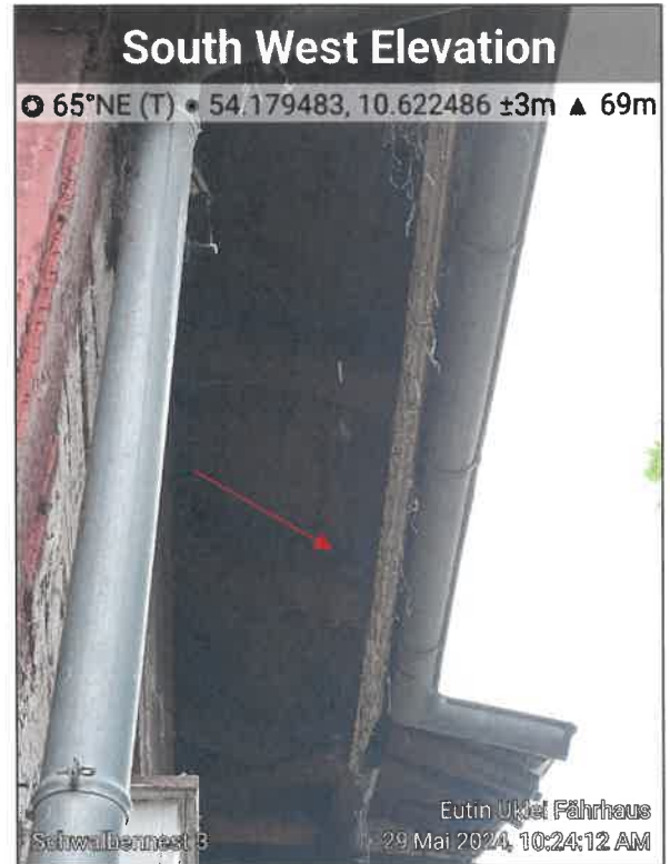
Abbildung 18: Mehlschwalbennest am Dachüberstand Westseite von Gebäude 1 (Foto: Planungsbüro ALSE, 29.05.2024)
