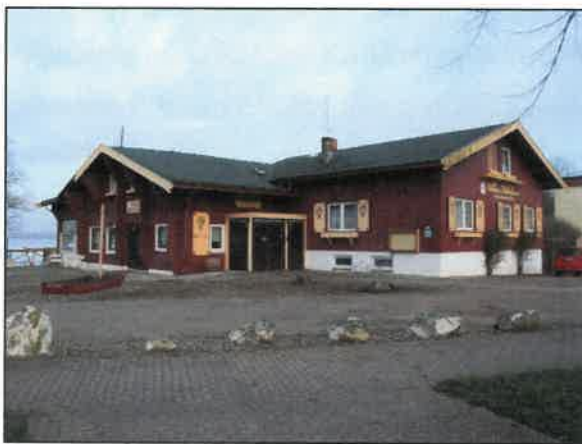
Abbildung 3: Restaurant und Café Ukleifährhaus (Gebäude 1), Blick aus Süden (Foto: Planungsbüro ALSE, 23.03.2024)
