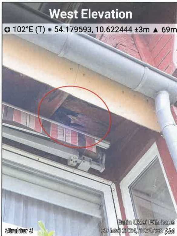
Abbildung 23: Nischenstruktur am Dachüberstand. Westseite von Gebäude 1 (Foto: Planungsbüro ALSE, 29.05.2024)
