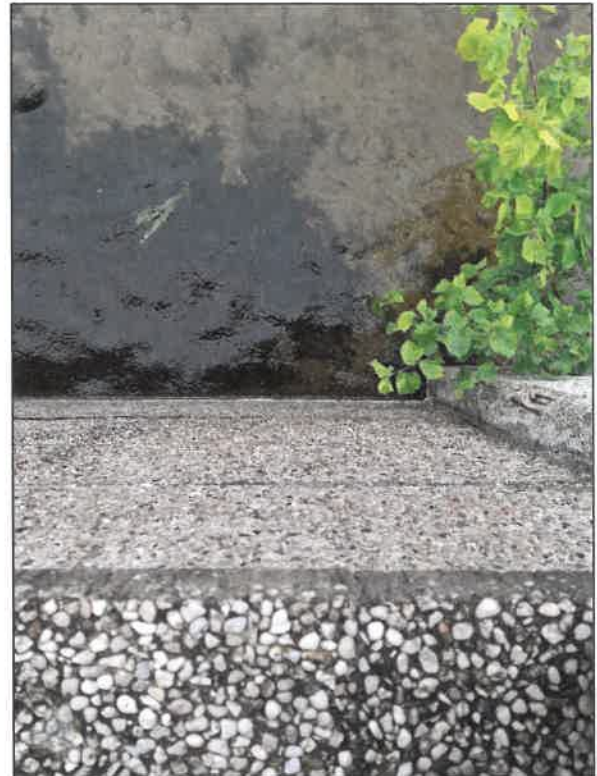
Abbildung 60: Massive Uferbefestigung am Kellersee (Foto: Planungsbüro ALSE, 29.05.2024)
