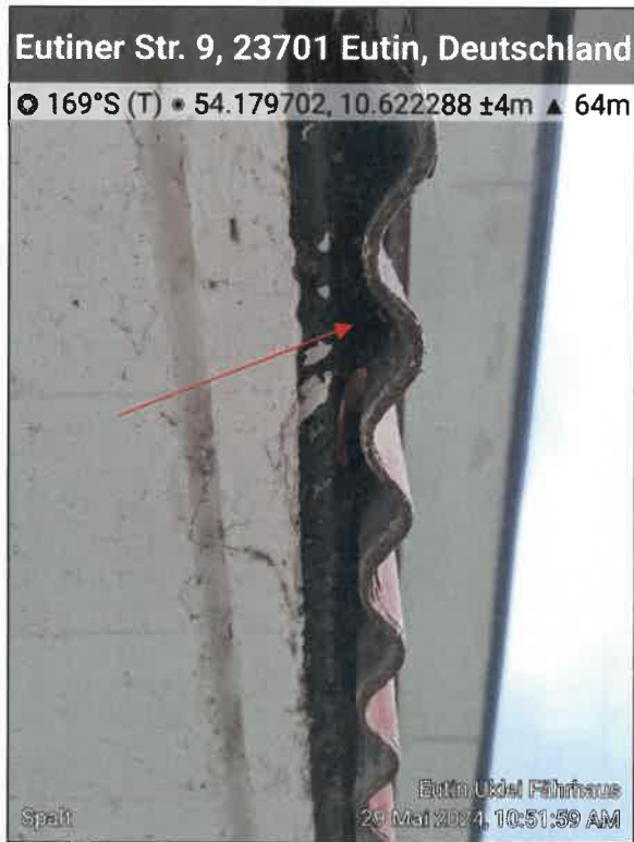
Abbildung 37: Spalt zwischen Ziegel und Fassade an der Westseite von Gebäude 1 (Foto: Planungsbüro ALSE, 29.05.2024)
