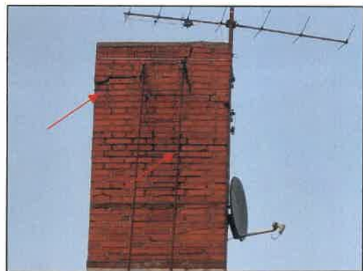
Abbildung 40: Potentielle Quartiere am Schornstein (Foto: Planungsbüro ALSE, 25.08.2024)
