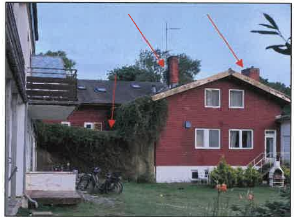
Abbildung 38: Schlingknöterichbewuchs am Gebäude und Schornsteine mit potentiellen Fledermausquartieren (Foto: Planungsbüro ALSE, 09.07.2024)
