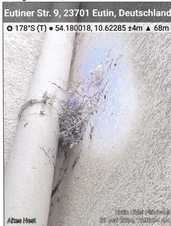
Abbildung 53: Altes Nest hinter Regenrohr, Ostseite Gebäude 2 (Foto: Planungsbüro ALSE, 29.05.2024)
