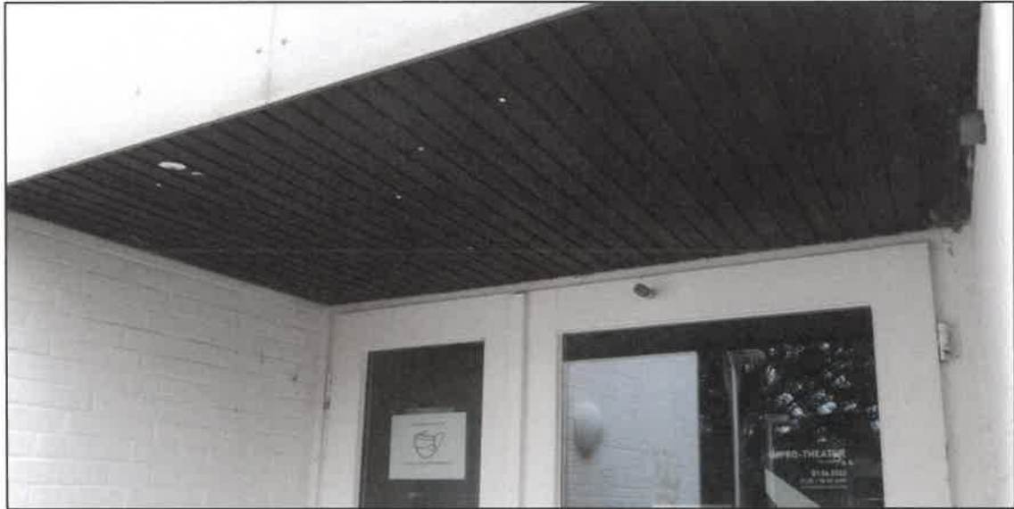
Abbildung 4: Dachüberstand an den Eingängen. Völlig abgedichtete Konstruktion (31.07.2022).
