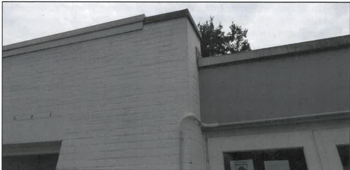
Abbildung 3: Beispielansicht der Fassade und der Dachkante ohne Spalten (31.07.2022).
