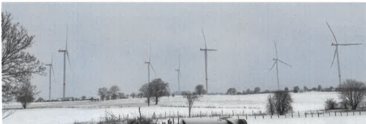
Abb. 10: Blick auf den TG 1 mit dahinter liegenden bestehenden WEA von der Siedlung Schwienkuhlen aus
