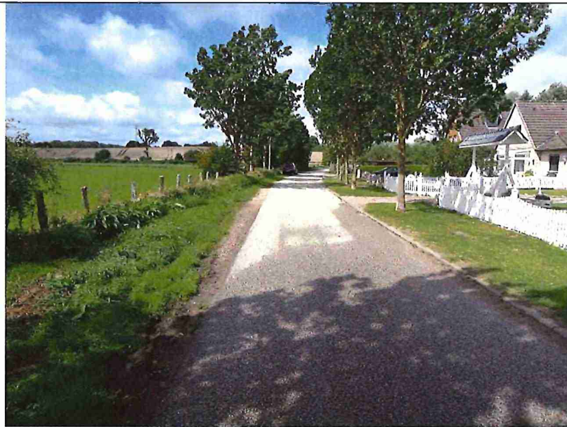
Abbildung 4: Einzelbäume und Ruderalflur entlang der nördlichen Grenze, Wohnbebauung und Baumreihe auf der gegenüberliegenden Seite, Foto vom 08.08.2023
