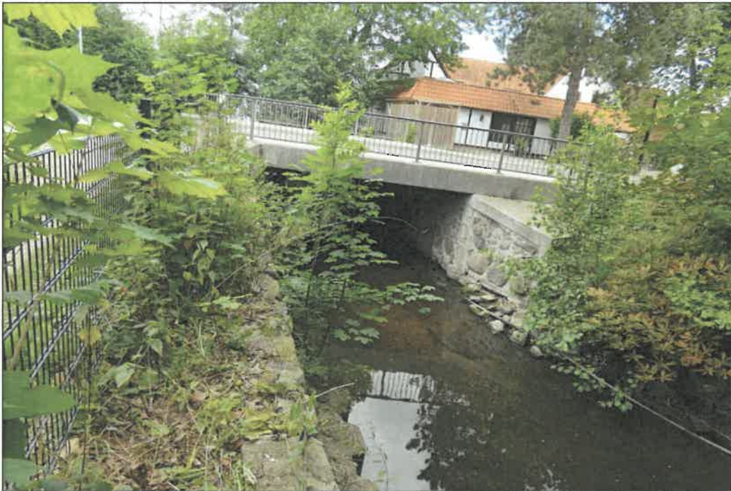
Abbildung 6: Vollständig verbaute Uferabschnitte unter der Schwentine-Brücke angrenzend an den Plangeltungsbereich.
