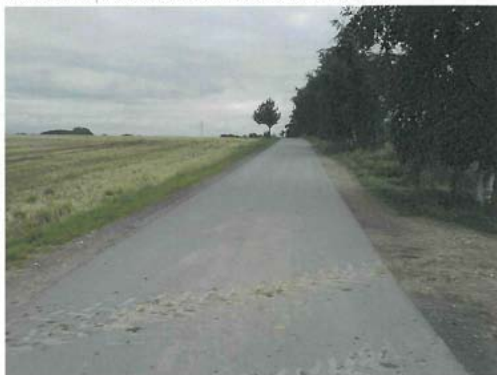
Foto 7 : Straße: „Luschendorfer Hof“ mit Einfahrtbereich zum Luschendorfer Hof
