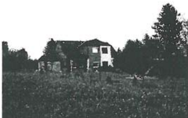
Rückwärtiger Blick auf die südlich des Schürsdorfer Weges angrenzende Bebauung
