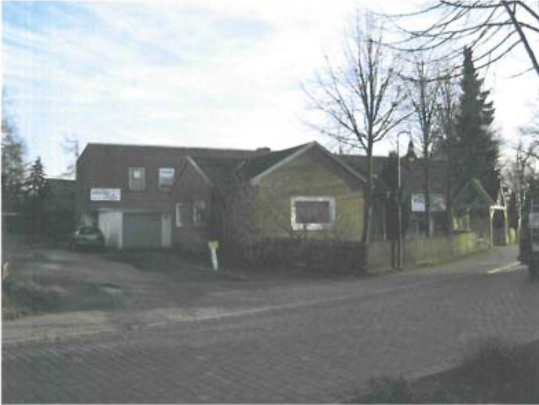
Foto 2: Leerstehendes Wohngebäude nebst Garage
